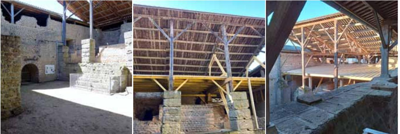
Depuis 2021, des **TRAVAUX DE PROTECTION** (étaisements des charpentes des toitures de protection des thermes) ont été mis en oeuvre par l'entreprise Renofors. La poursuite des travaux s'effectue cette année : il est prévu le renforcement des charpentes sur l'ensemble des thermes.
